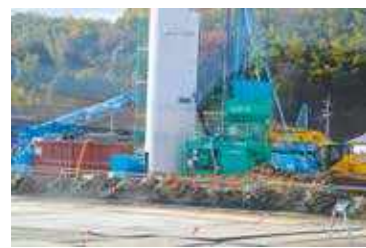
▲建物保証は2年間と定めた新永康病院・新設建物現場
