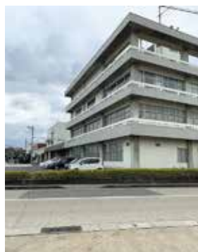
▲倒壊の危険がある旧詫間町庁舎
