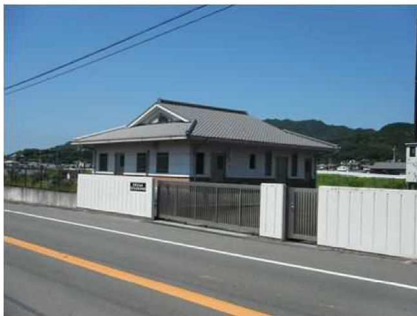
写真 2-1 北草木地区農業集落排水施設
