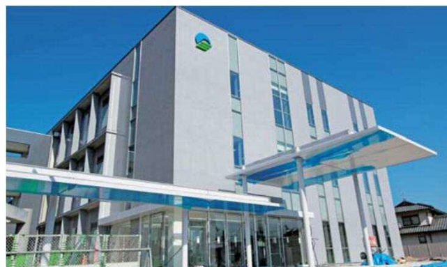
▲建設中の危機管理センター
