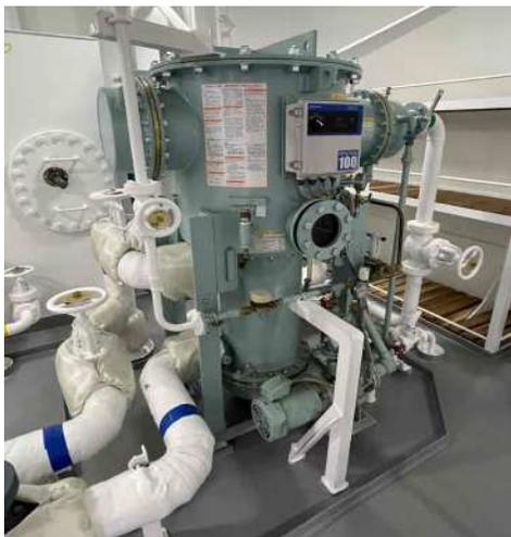
航海中のエンジン排熱を利用した海水から真水を作る造水器を搭載する事で船内生活用水を確保、給水量の大幅な削減を可能とし省エネ・省資源に取り組みます。
