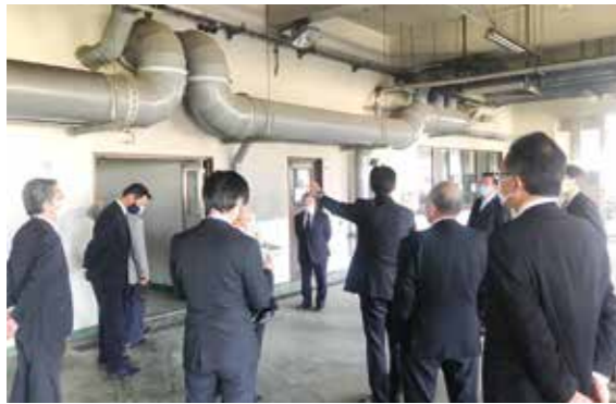
▲ 旧三豊クリアプラザの現地調査の様子
