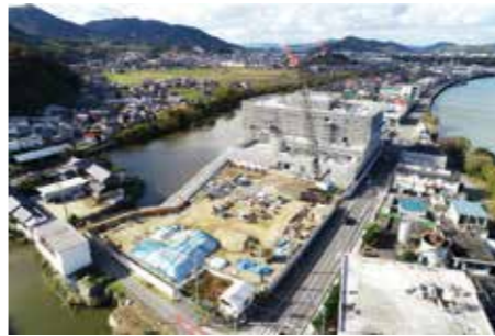
▲ 建設中の新病院（三豊市詫間町詫間）
