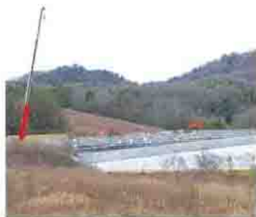
▲建設が進む南部給食センター
