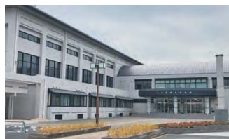
▲改修工事が終了した三豊市総合体育館
